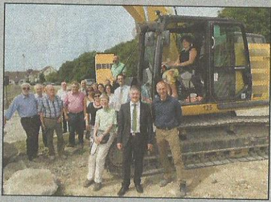
Seite 3 Erschließungsarbeiten für das Projekt Bahnstadt haben begonnen
